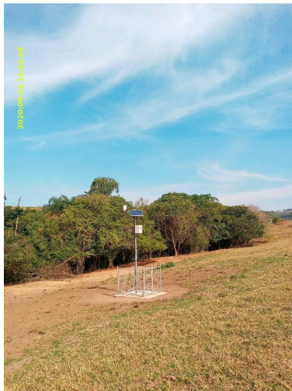
Estação Telemétrica Limpa (longe)
