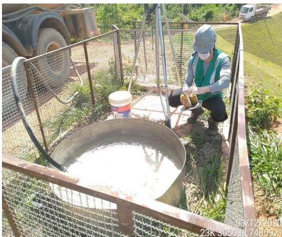
Foto 6 – Limpeza do tanque do reservatório e do medidor de nível. (Data: 03/12/2020).
