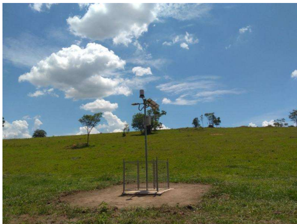
Estação Telemétrica Limpa (longe)
