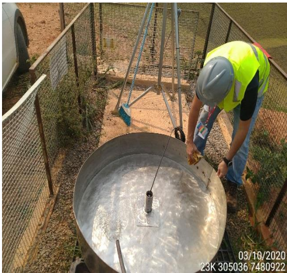
Foto 4 – Limpeza do tanque do reservatório classe A. (Data: 03/10/2020).
