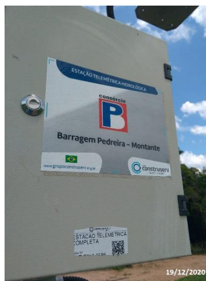
Foto 8 – Estação Hidrométrica Barragem Pedreira montante (Data: 19/12/2020).
