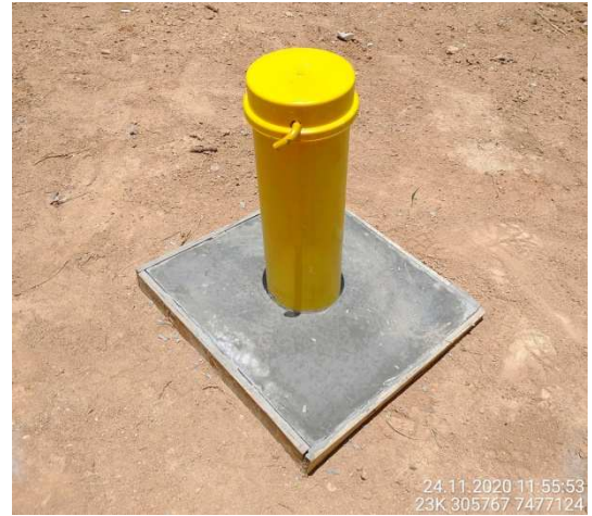
Foto 2 – PM-BP-01 finalizado e com o acabamento de proteção. (Data: 24/11/2020).
